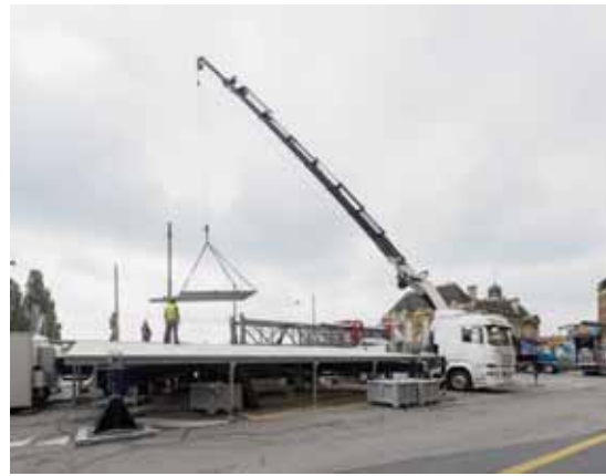
Sept camions et une grue ont débarqué lundi, mais la Spin Tower n'a commencé à être montée que le lendemain; d'abord la base, puis chaque élément. Installation terminée mercredi après-midi.
