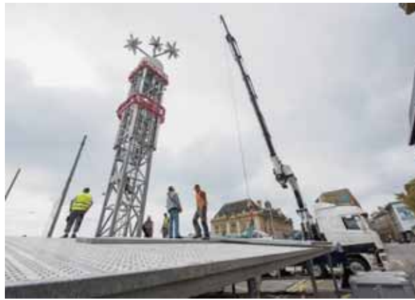
Sept camions et une grue ont débarqué lundi, mais la Spin Tower n'a commencé à être montée que le lendemain; d'abord la base, puis chaque élément. Installation terminée mercredi après-midi.
