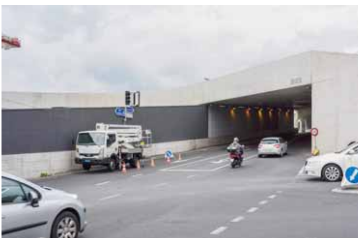
Jeu, lors de la pose de la signalisation lumineuse. CHRISTIAN GALLEY
