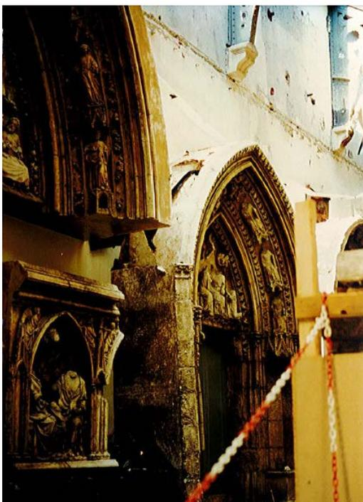
*Fig. 23 Dépôts de suie visibles sur les moulages suite à l'incendie de 1997. © MMF/CAPA, 1997.*
