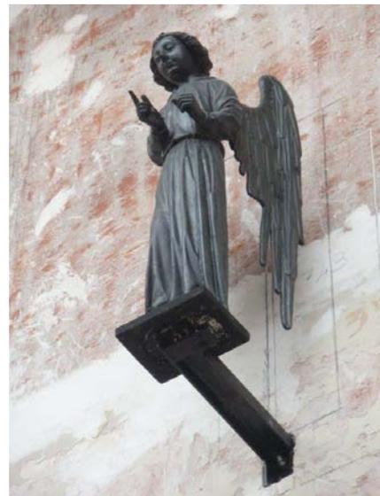
**Fig. 57** Fixation moulage de petites dimensions
