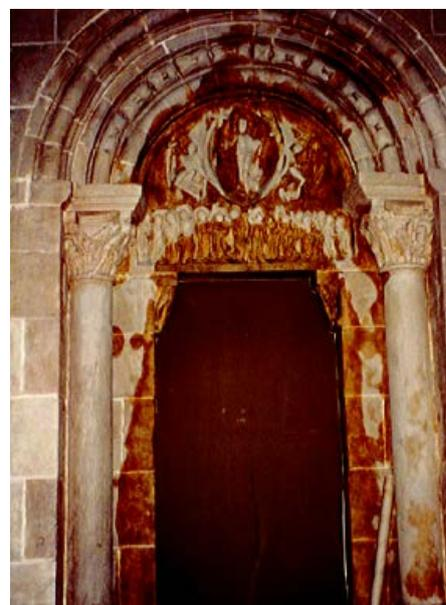
**Fig. 24** Taches résultantes des remontées de tanins sur les moulages après l'incendie de 1997. © MMF/CAPA.
