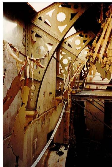
*Fig. 41 Des éléments de la toiture se sont effondrés suite au sinistre © MMF/CAPA, 1997.*
