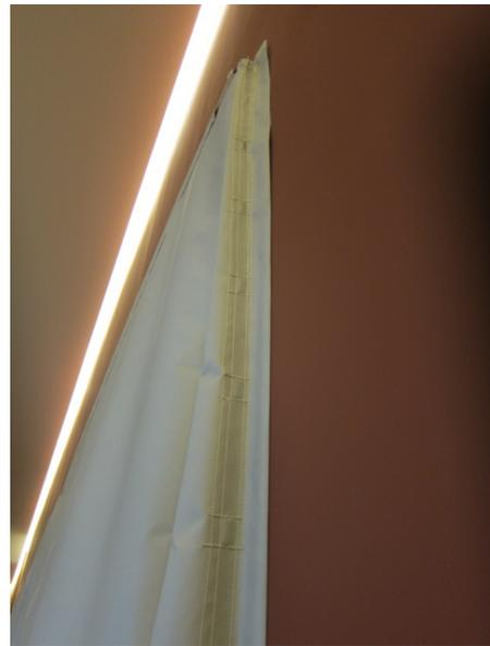
*Fig. 65* L'écran assure une étanchéité contre les suies. © MBAD, 2012.
