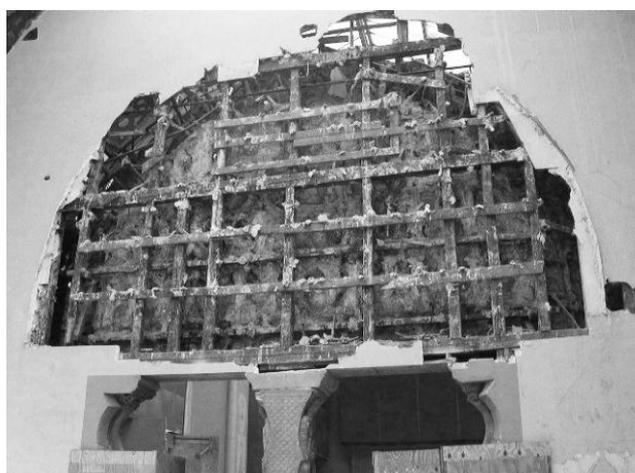
*Fig. 12 Vue de l'arrière du portail de Moissac et de sa structure portante en bois. © MMF/CAPA, 2005.*
