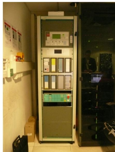
*Fig. 31* Vue de la baie numérique du système de sécurité incendie de la CAPA, situé au poste centrale de sécurité. © A.D., 2015.
