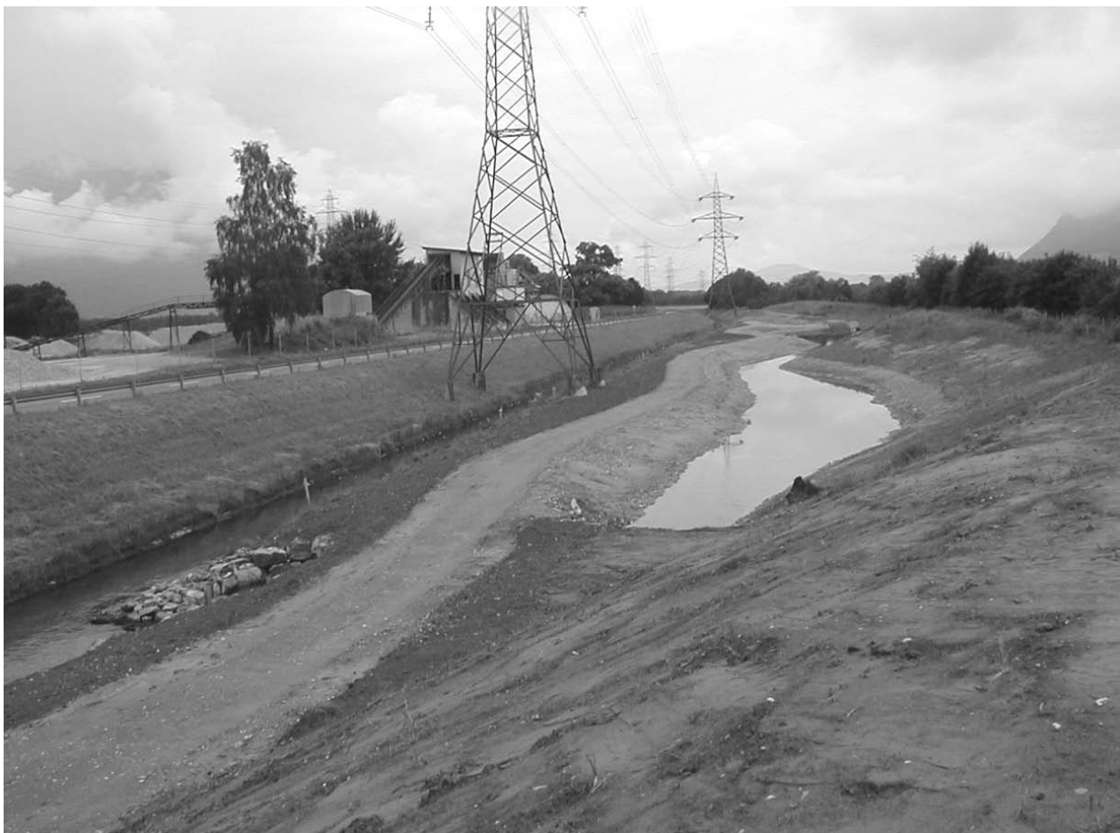
Figure 2. Vue du site à la fin des travaux (juillet 2002)
