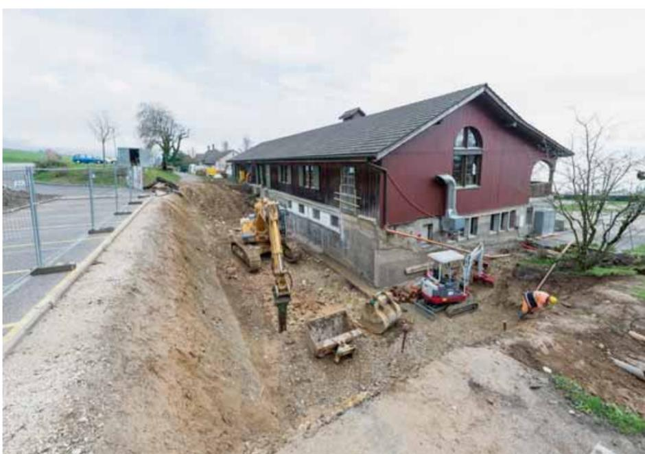
Derrière le bâtiment principal, les travaux de terrassement doivent permettre une extension du sous-sol.
