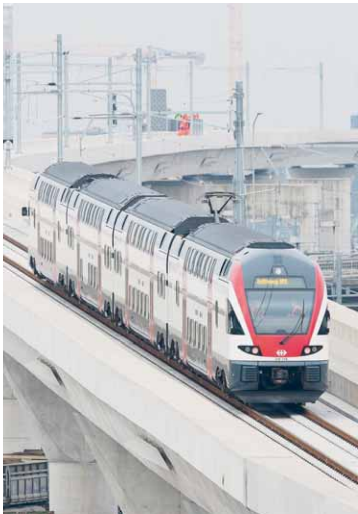
Hier a été inaugurée la ligne diamétrale dans la gare de Zurich. Cela permet aux trains grandes lignes de passer sur deux ponts pour atteindre la nouvelle gare souterraine. KEYSTONE
