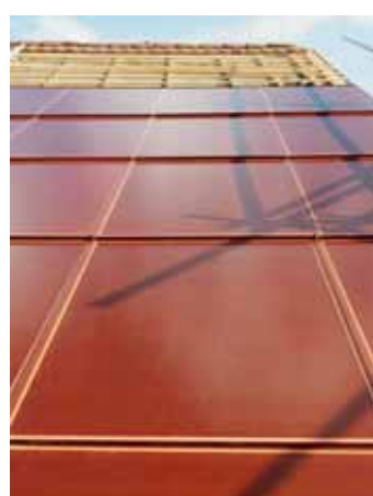
Les panneaux aux jointures étanches permettent de se passer de tuiles. DAVID MARCHON
