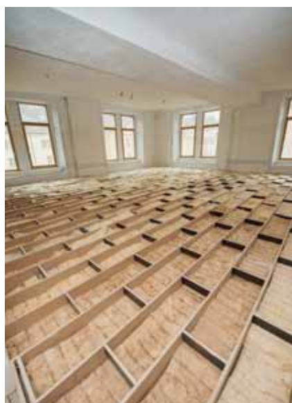
Mise à niveau du sol dans l'espace danse.
