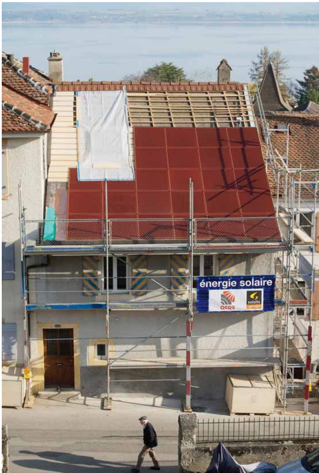
Les panneaux photovoltaïques couleur terre cuite dans leur nouvel environnement. DAVID MARCHON
