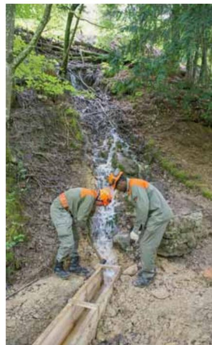
Deux pionniers en train de finaliser l'installation de la rigole en travers du sentier.
