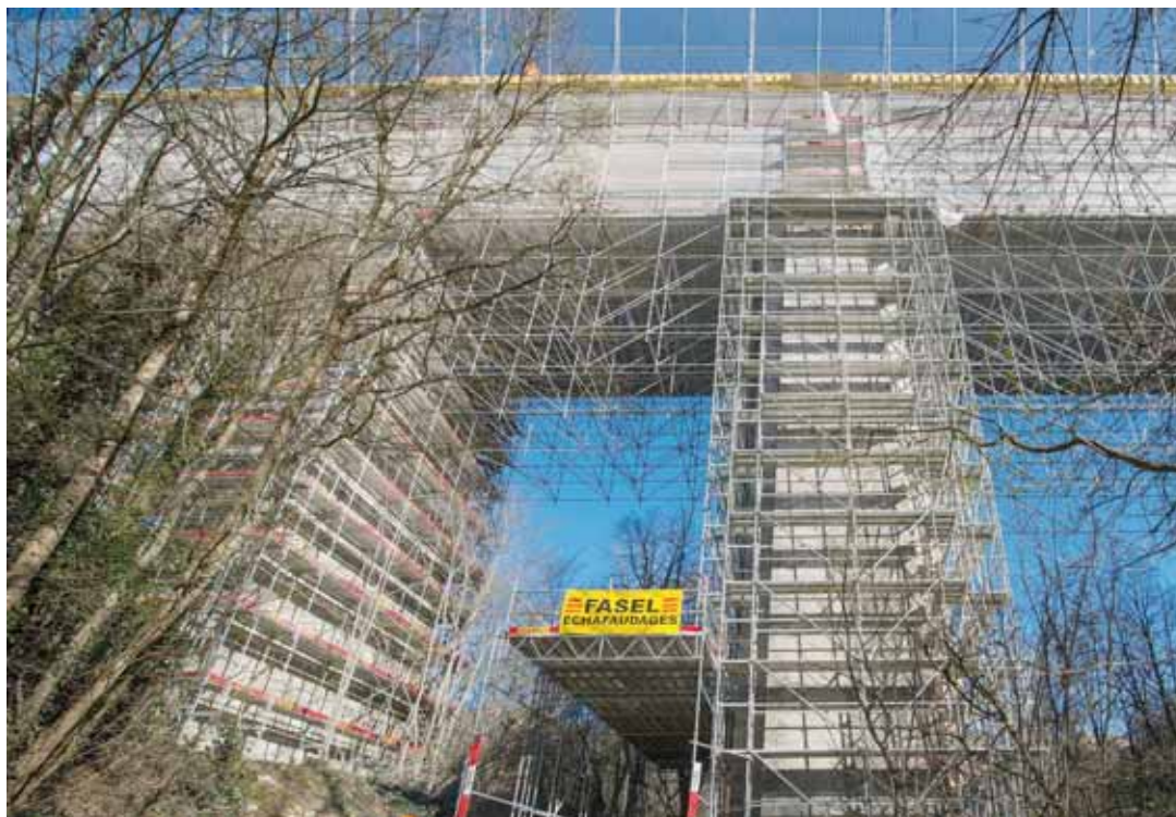
Le viaduc aux onze arches enjambe l'Areuse à près de 40 m du sol. Un entrelacs d'échafaudages permet de travailler sur les voûtes. DAVID MARCHON
