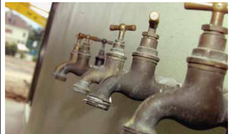
Un mystérieux vol de robinets sur le chantier du futur siège des services secrets à Berlin suscite les moqueries de la presse et des internautes.
