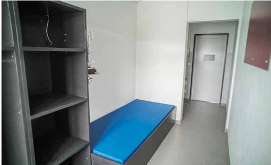
Cellule après transformation, une fois les travaux de rénovation de la prison terminés. ARCHIVES CHRISTIAN GALLEY
