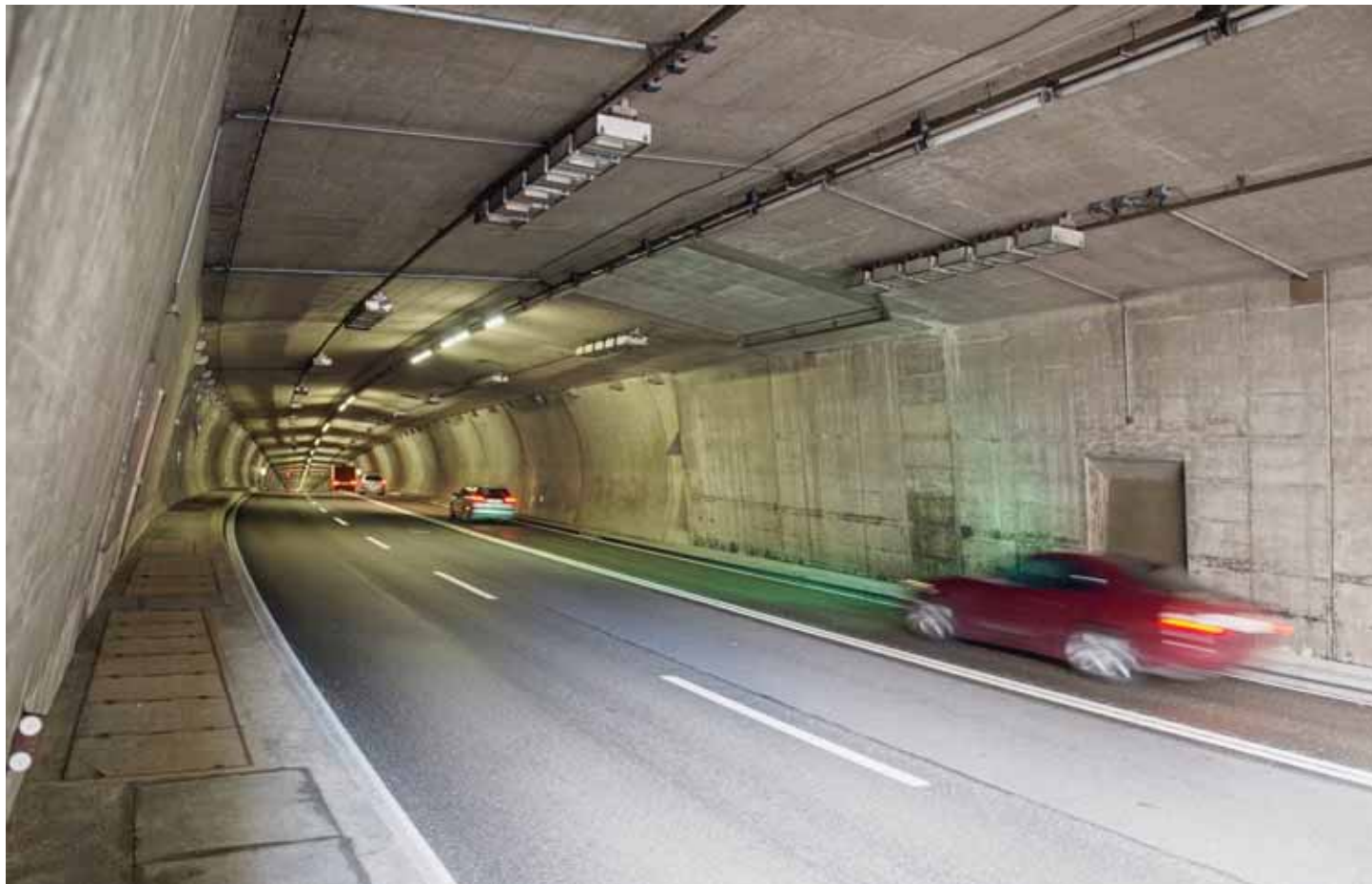
Le tunnel de la Clusette dans son aspect actuel. Le faux plafond pourrait à terme disparaître, mais cette option doit encore être validée. DAVID MARCHON
