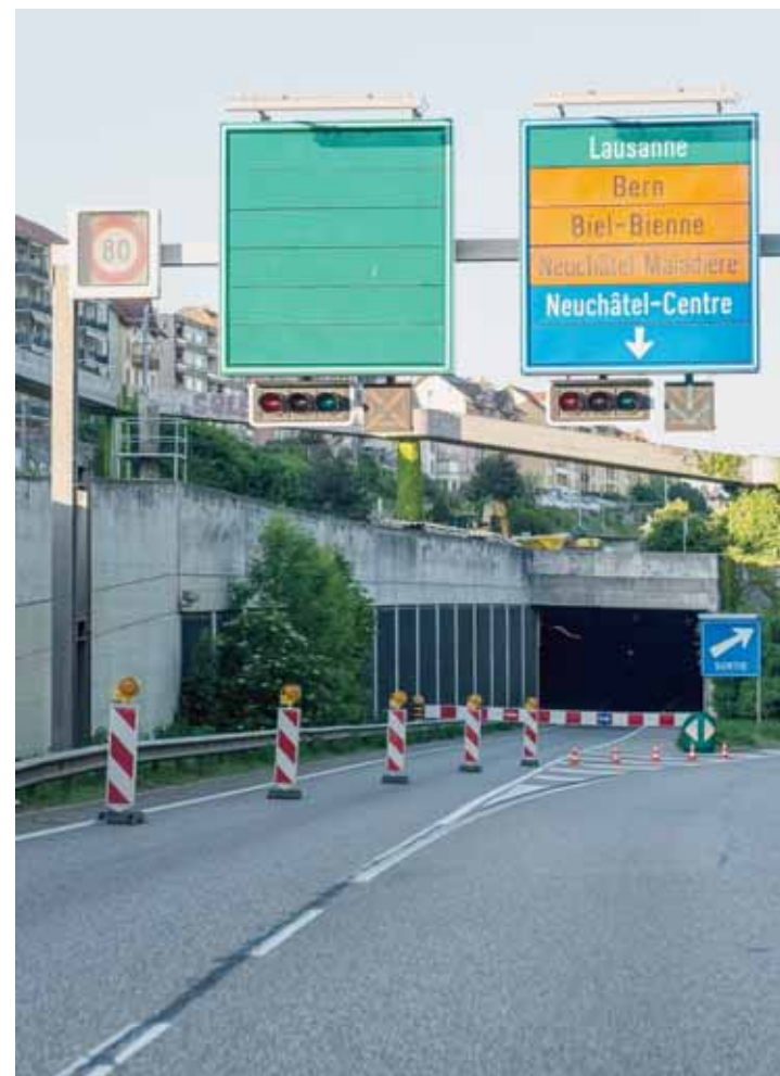
Depuis hier soir, la jonction de l'A5 à Vauseyoyon est fermée de nuit au trafic. LUCAS VUITEL
