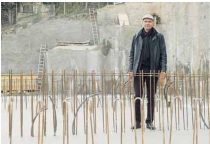
Mustafa Labidi sur un chantier de l'avenue des Alpes, à Neuchâtel, où se construit un bâtiment de onze appartements en PPE. DAVID MARCHON
