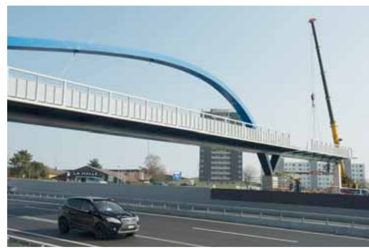
La passerelle est posée dans son entier. Il manque encore à installer les rampes d'accès pour qu'elle soit utilisable, vers la mi-mai. DAVID MARCHON
