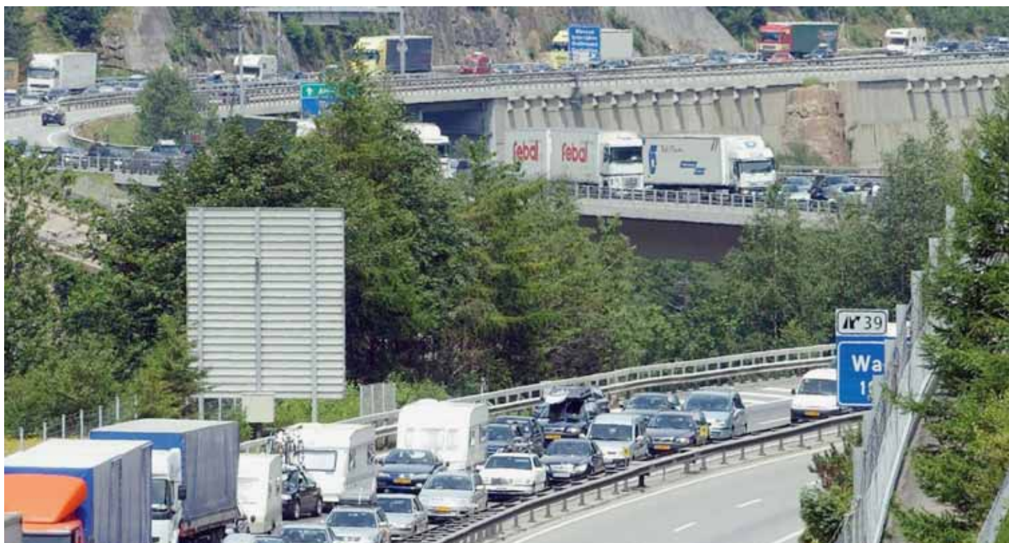
Faut-il percer un second tube routier au Gothard? La réponse des Neuchâtelois aura-t-elle un impact direct sur les gros chantiers du canton? KEYSTONE
