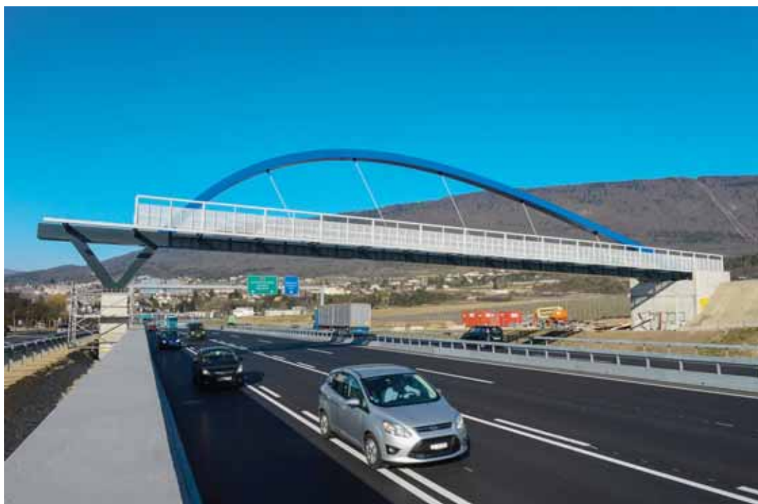
La partie centrale de la passerelle de La Tène est en place. Les travaux se poursuivront le 18 mars. CHRISTIAN GALLEY
