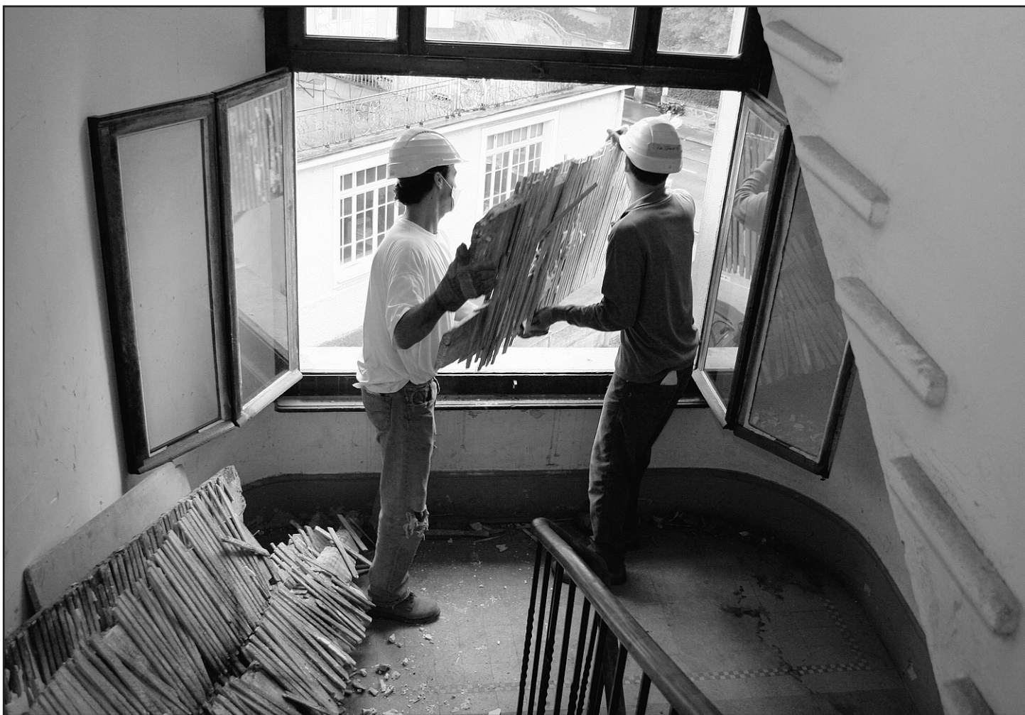
L'une des tâches de la Thune à Sion est la déconstruction. Un vieil immeuble de Martigny a besoin d'être vidé avant rénovation? Les participants de l'entreprise sociale s'y attellent. LE NOUVELLISTE
