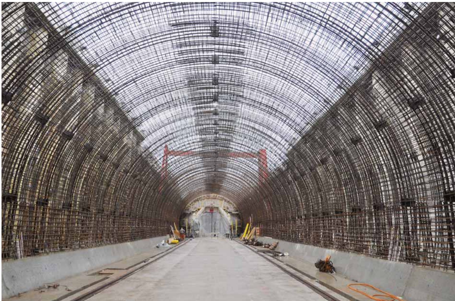
La galerie de Malleray se situe sur le tronçon de 8,8 kilomètres encore en chantier entre Court et Loveresse. Longue de 548 mètres, cette tranchée couverte accueillera le trafic dans un seul tube. La décision de réaliser la route en souterrain dans cette zone répond à une volonté politique de réduire au minimum les emprises sur les surfaces agricoles utiles. SP-A16 INFO
