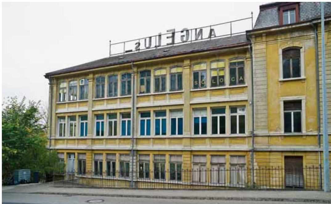
Le bâtiment n'est plus chauffé depuis le 14 janvier. L'eau a été coupée avant-hier. Un casse-tête pour le dernier occupant du bâtiment, qui loue un studio dans les combles. ARCHIVES RICHARD LEUENBERGER
