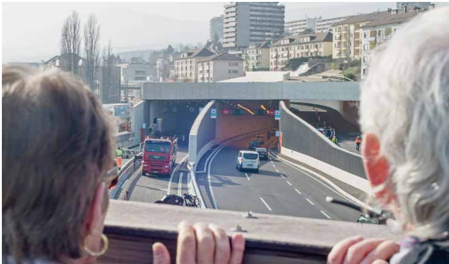
Après le tunnel de Serrières et les «UPlans» sur l'A5 à Colombier et Cornaux, le secteur du génie civil attend de pied ferme les prochains travaux dans les tunnels de Neuchâtel, qui devraient démarrer en 2016. Mais il n'y en aura pas pour tout le monde. ARCHIVES DAVID MARCHON
