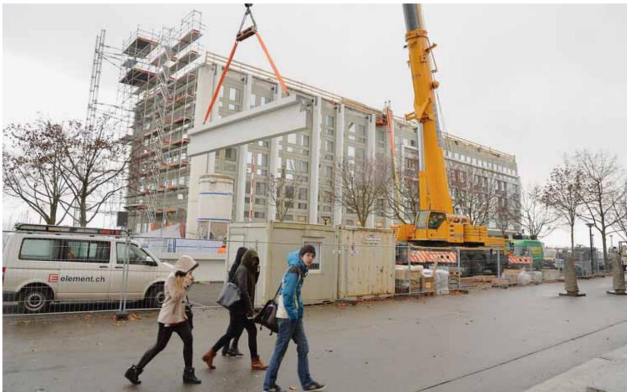
Les imposantes structures de béton préfabriquées sont posées à l'aide d'un camion-grue à cinq essieux. RICHARD LEUENBERGER
