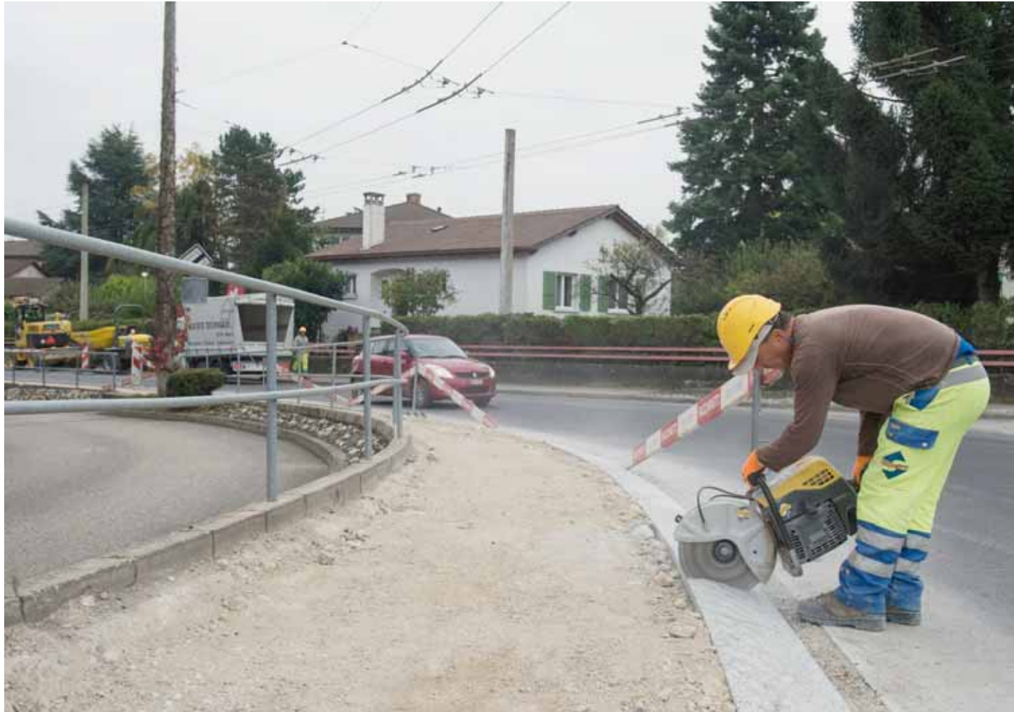
Des bordures franchissables, en granit, sont posées sur tout le tracé de la rue de la Gare en rénovation. DAVID MARCHON
