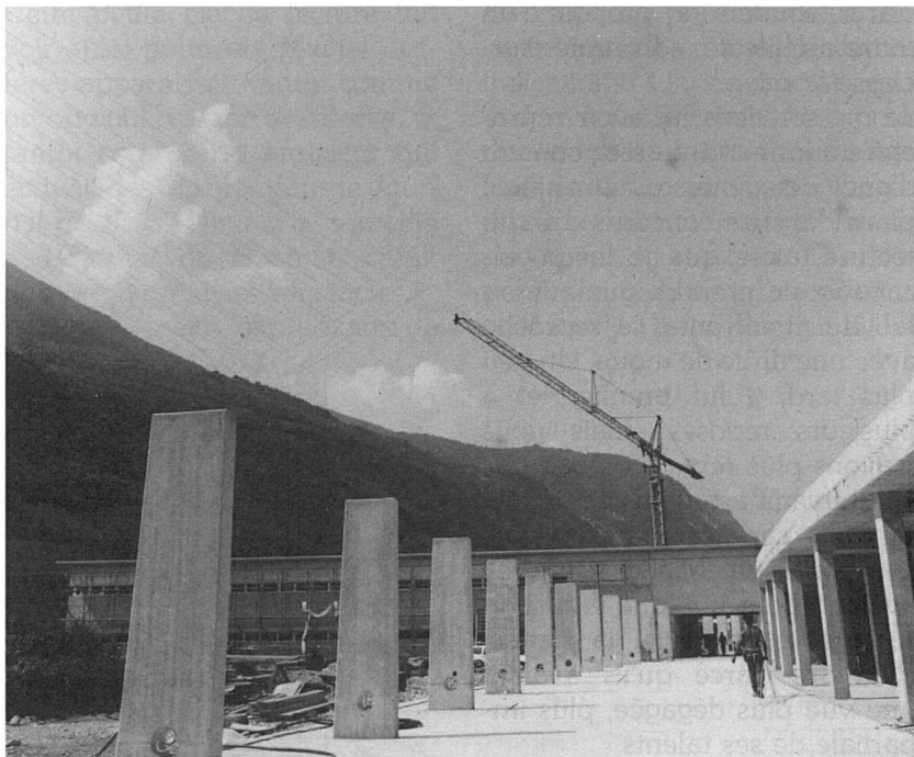
Centre cantonal d'instruction de protection civile de Grône
