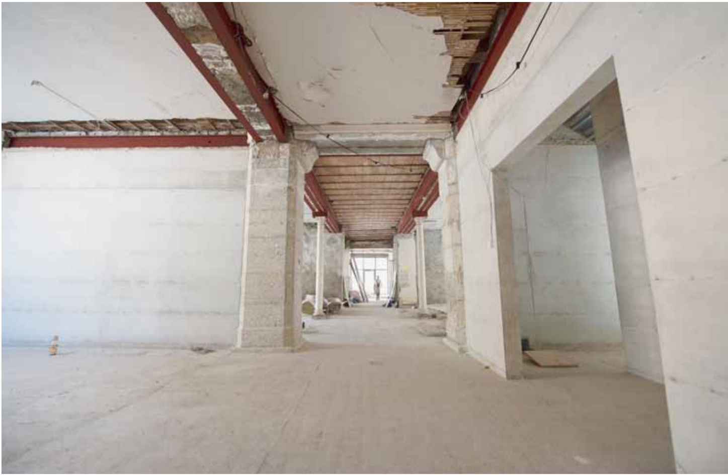
Vue des locaux en rénovation de l'Ancienne Poste, prise en juin dernier. Elle ouvre ses portes ce samedi, de 11h à 16 heures. ARCHIVES DAVID MARCHON
