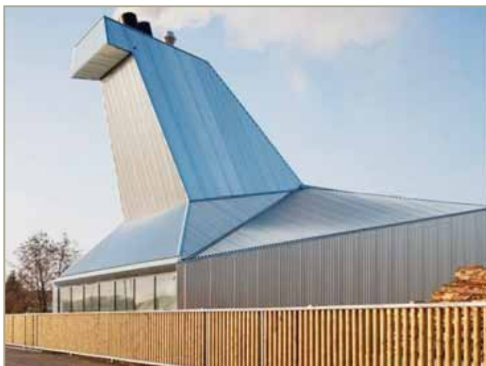
La conséquente installation du chauffage à distance de Lignières. SP
