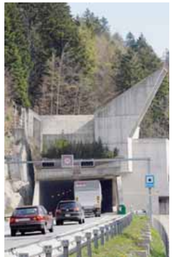
L'entrée du tunnel aux Hauts-Geneveys. KEYSTONE
