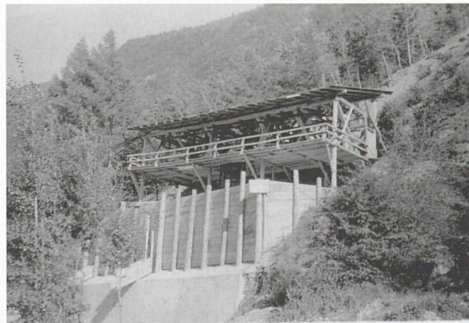
Station d'arrivée du câble de l'exploitation minière de Chemin au Cottentin près du Guercet; à droite, on devine la tranchée faite à travers la forêt (25.8.1940).
