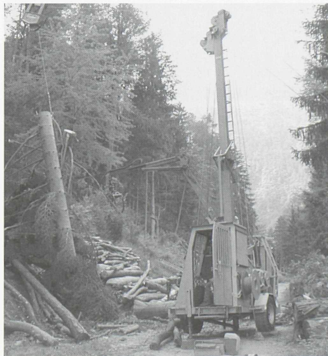
Fig. 13 – Le câble-grue en action sur la route forestière des Planches.
