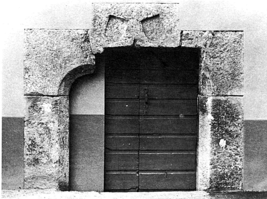
Porte gothique, face nord, état actuel.
