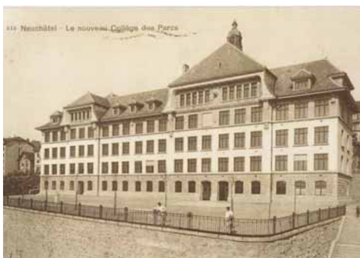
Le collège des Parcs a été construit en 1914. SP
