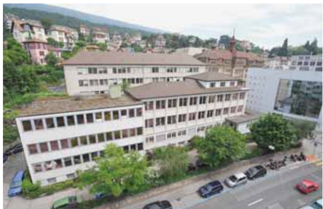
2010 Le quartier avant les travaux. Les deux bâtiments au premier plan, dont l'Ecole professionnelle commerciale du CPLN, et au fond le collège de la Maladière seront démolis. Il faudra aussi désamianter et lever quelques oppositions de voisins inquiets de la hausse du trafic.
