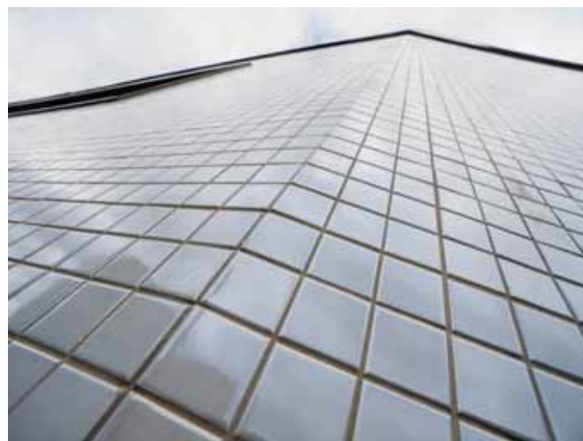
LE CARRELAGE EN FAÇADE Il y a plus de 750 000 éléments! Les modules en céramique de 5 cm x 5 cm évoquent, en façade, des microsystèmes mis bout à bout. Leur coloration a été créée spécialement pour Microcity. PHOTOS CHRISTIAN GALLEY
