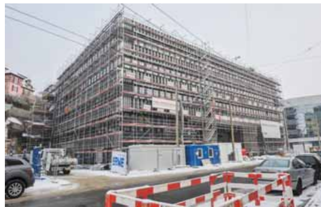
2013 Au sortir de l'hiver Microcity prend forme, le gros-œuvre a été terminé en octobre 2012. Les passants voient s'élever le grand bâtiment qui, une fois débarrassé de ses échafaudages, accueille ses premiers occupants en septembre. Suivront les aménagements extérieurs.
