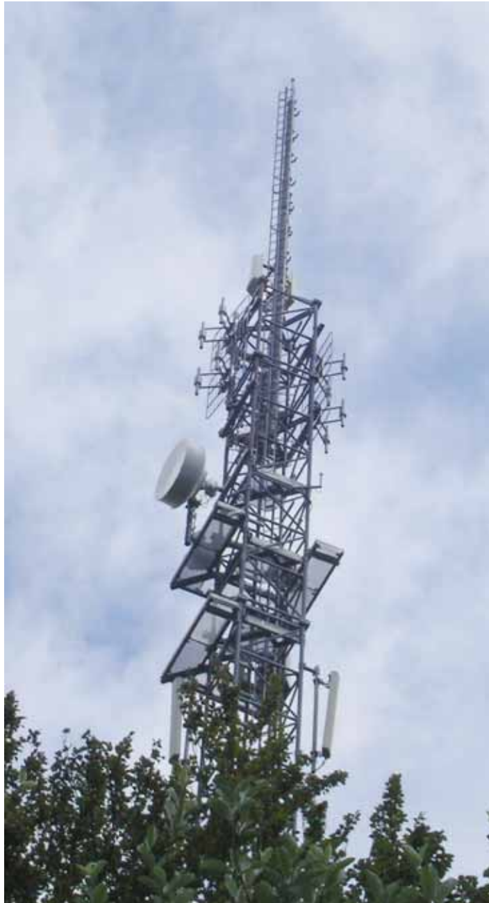
Un émetteur radio-TV au Val-de-Travers: pour la bande FM, la télévision numérique et le DAB+. SP
