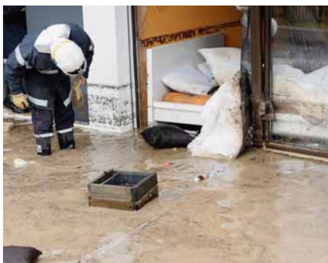
SUISSE Dégâts. Maison inondée suite aux intempéries à Moudon (VD). La ligne de train Moudon-Ecublens-Rue restera encore interrompue plusieurs jours à cause d'un glissement de terrain. KEYSTONE
