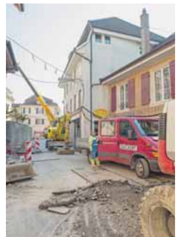
Les travaux à la rue du Temple. ARCHIVES DAVID MARCHON
