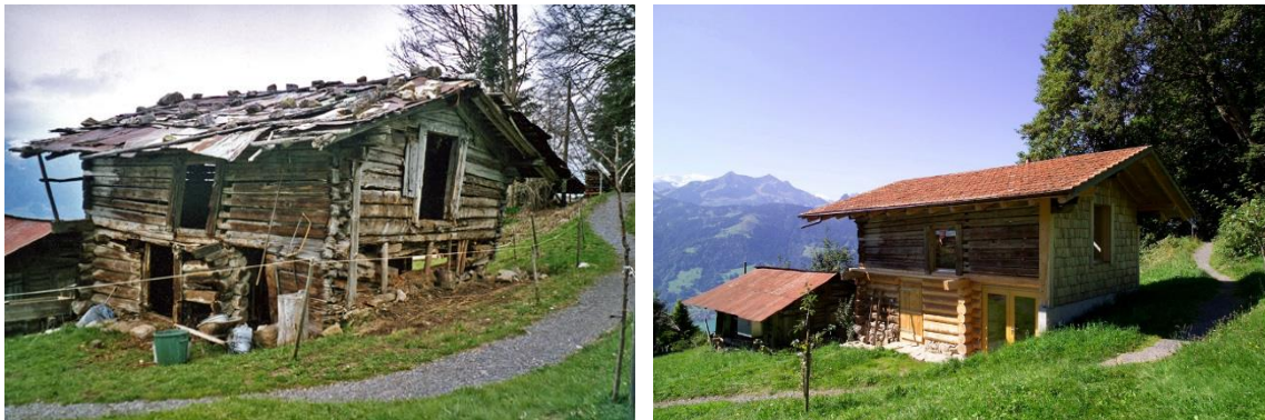
Figure 7. Maison Scheune : avant – après
