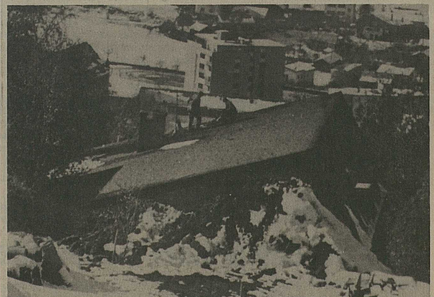
La villa, située sur la pointe d'une colline dominant Brigue. On remarque les pompiers sur le toit partiellement endommagé par le sinistre.
