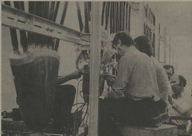
Une équipe en train de souder les fils. A gauche, on peut voir le résultat de l'opération : le câble de 110 mm (4800 fils) est relié au central et ressort en haut divisé en 10 câbles plus petits.
