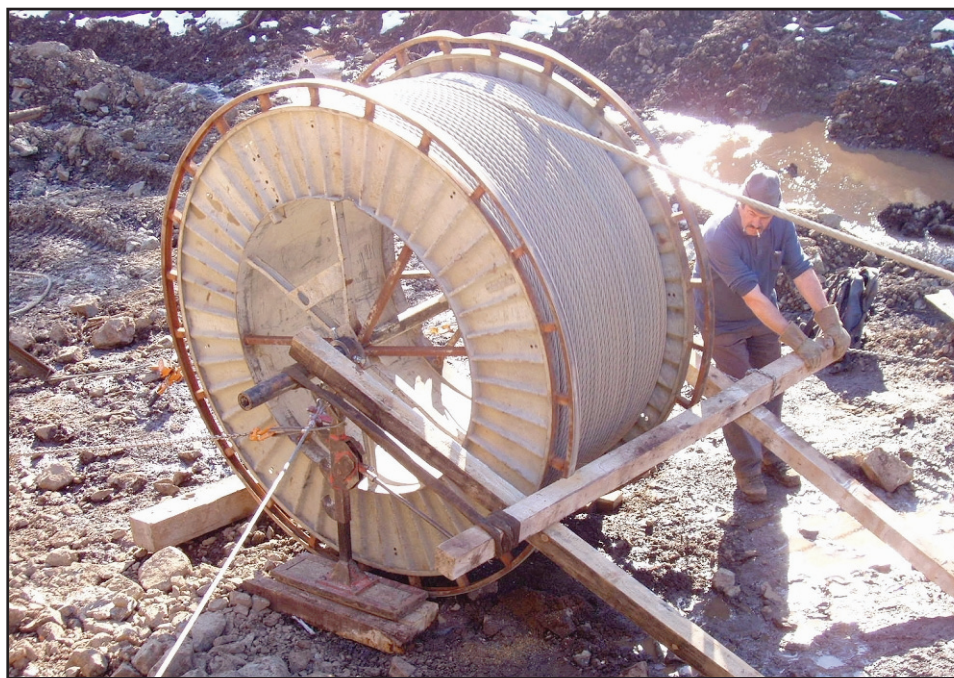
Pierre-Denis Perraudin freine «à l'ancienne» le déroulement du câble! DR
