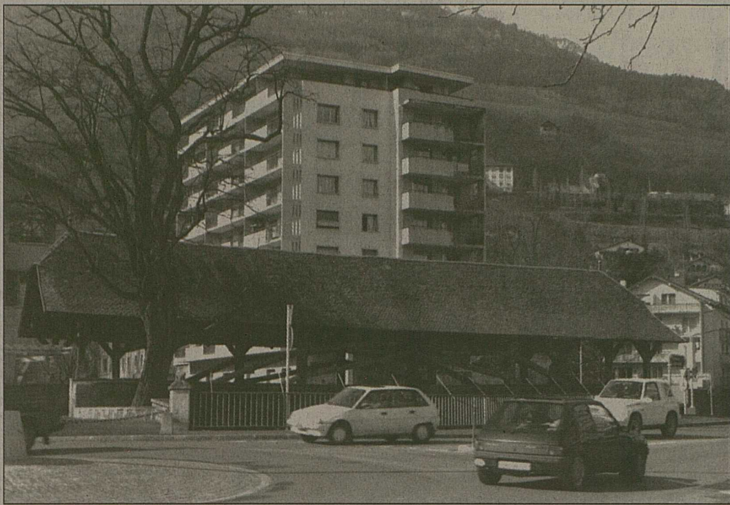
200 000 francs sont nécessaires pour la rénovation du Vieux-Pont en bois de Monthey, propriété de la commune.
