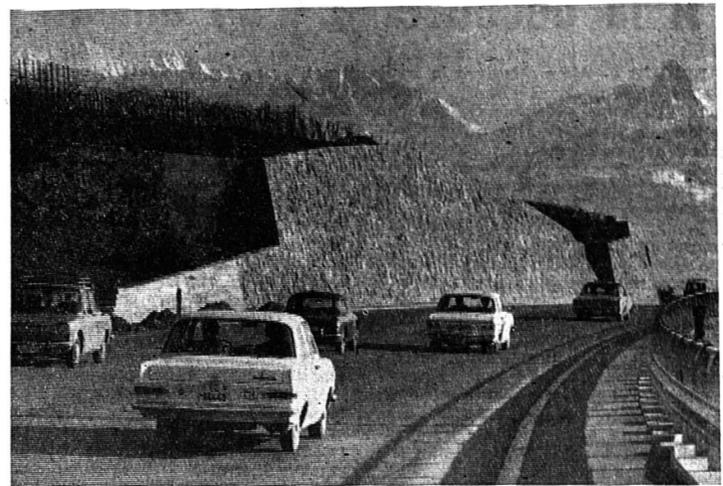
Les grands travaux de correction de la route cantonale 780, à l'entrée de Vevey, côté Lausanne, sur les communes de Chardonne et Corseaux sont presque achevés. La chaussée a été portée de 9 m à 12,50 m, plus deux trottoirs de 1,50 m sur une distance de 1.500 m. D'imposants murs ont dû être construits pour soutenir le vignoble.
