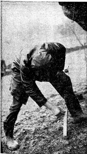
M. Pierre Chappex, contremaitre au service des travaux publics de la commune de Monthey, contrôle l'affaissement du bloc au moyen d'un piquet planté en terre et sur lequel est pendu un fil à plomb. En une heure, l'affaissement a été de 6 cm.
