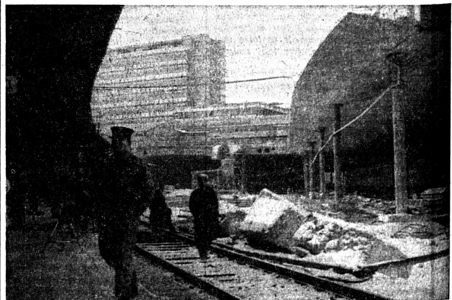
Les travaux de la gare de Berne seront bientôt terminés. Dans quelques jours, on ne verra plus le ciel, car on vient de commencer les travaux sur la voie 1. NOTRE PHOTO : une vue de l'état actuel des travaux dans la gare de Berne.
