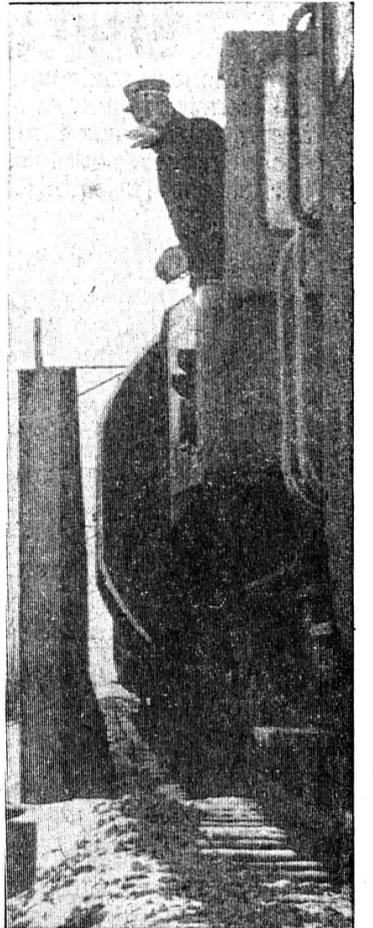
Comme la traversée du tunnel de St-Maurice, le passage du « Pont Rouge » qui enjambe la Vièze, a exigé que le convoi roule à 5 km/h non seulement du fait du poids du convoi, mais de la largeur de celui-ci. Quelques centimètres séparent le parapet du pont et le stator.
