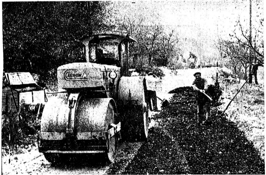
Sur le plateau de Brye: travaux d'asphaltage de la route.
