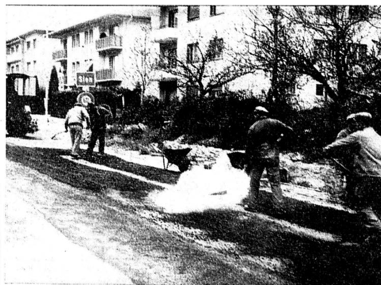
Des travaux sont actuellement en cours sur la route cantonale, à la sortie de Sion. Ils ont pour but de refaire le tapis, endommagé par le gel d'hiver. La circulation particulièrement intense après les fêtes de Pâques s'en trouve considérablement gênée par les différentes machines et engins se trouvant sur la chaussée déjà très étroite à cet endroit. (Photo M.G.)
