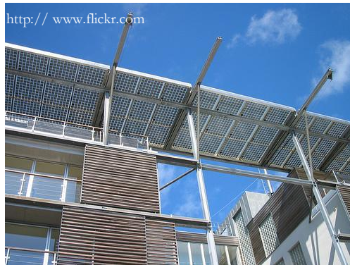
Figure 7 : Panneaux solaires « à longs bras », à Malmö, Suède
