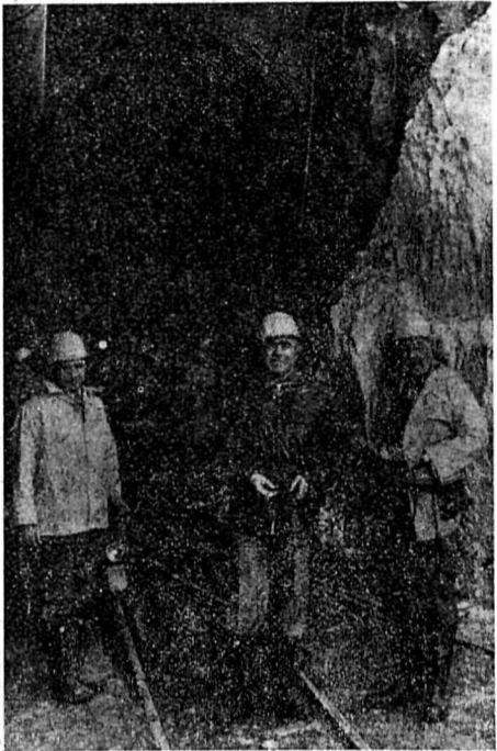
André Filippini en mineur (au centre) à l'entrée du tunnel de la Furka à Oberwald, tunnel qu'il construisait en consortium avec d'autres entreprises. (photo Valpresse, Sion)
