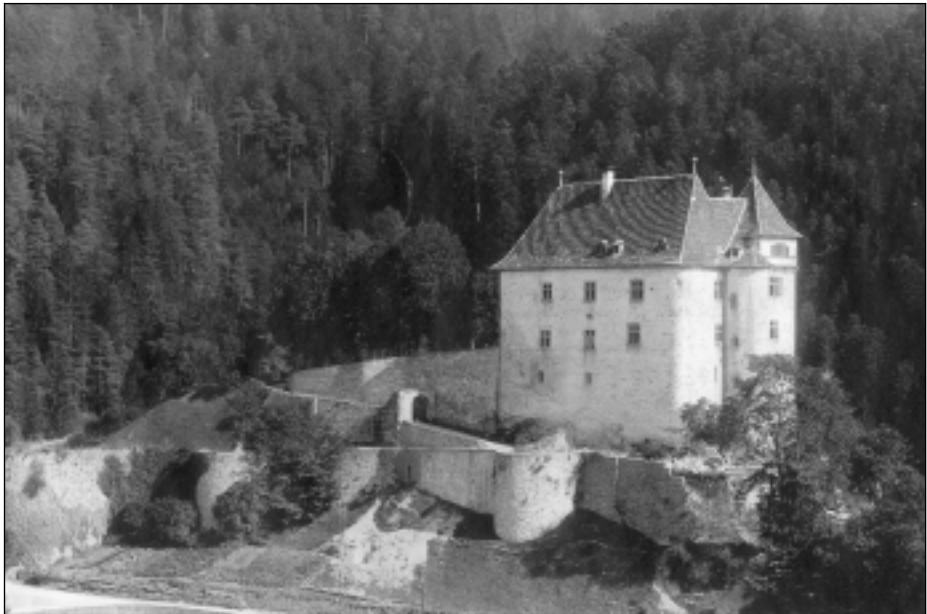
Fig. 4. Le château de Valangin depuis le sud-ouest pendant les travaux de Matthey (SPMS, MH n° 232, 1912).
