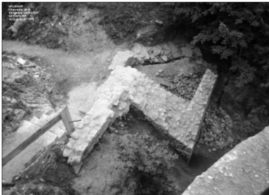
Fig. 14. Vestiges des aménagements du pont-levis de 1450 (SPMS, MH n° 1159, 1915).
