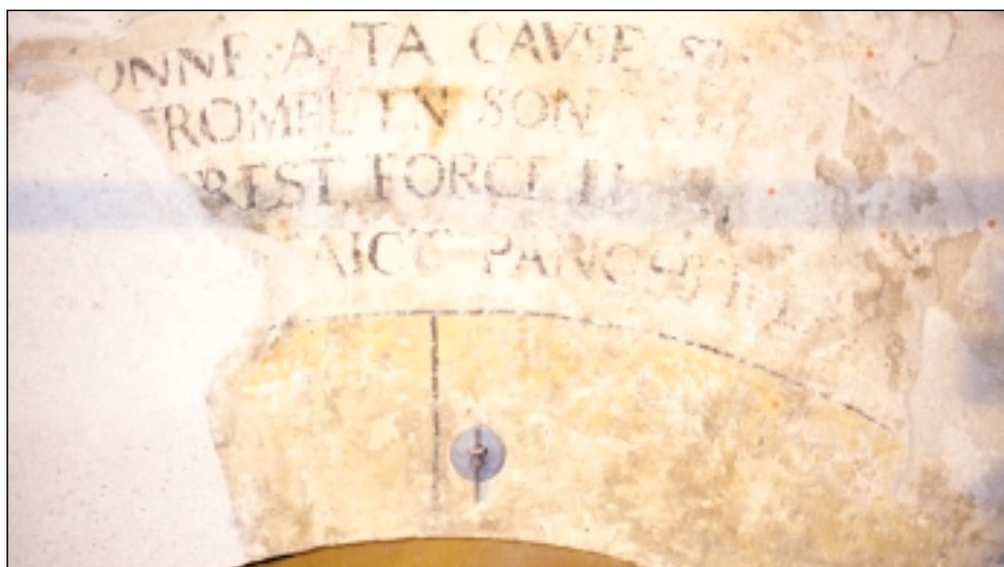
Fig. 14. Salle de justice , décembre 2000, complément à la fig. 13. Suppression des badigeons, détail de la mise au jour d'une inscription et d'un faux appareil.
