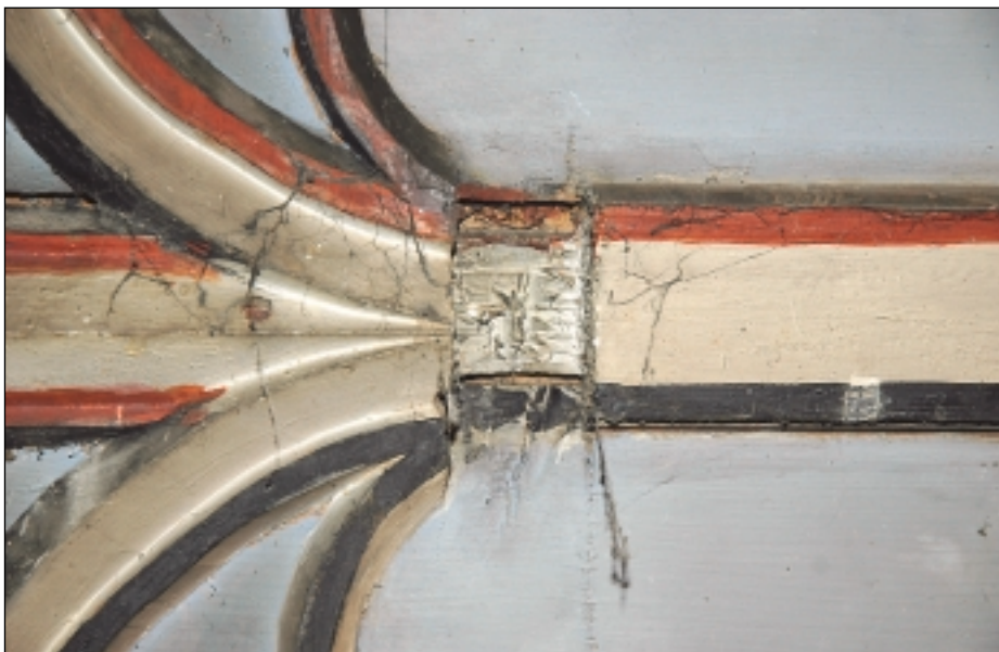
Fig. 7. Détail de l'entaille et taille grossière de la liste rainée pour permettre l'insertion de la frise à redents, à gauche sur l'illustration (Atelier Muttner).
