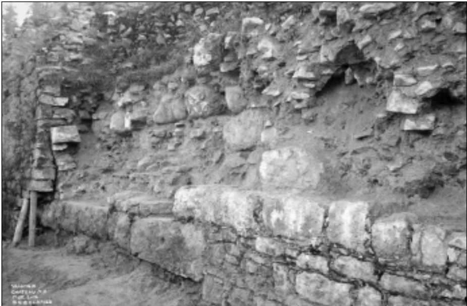
Fig. 11. Vestiges de l'enceinte en gros appareil à bossage du XIV e siècle (SPMS, MH n° 1166, 1915).
