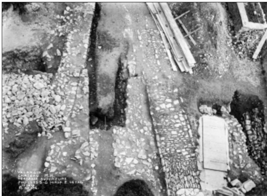
Fig. 18. Le parvis, ancienne haute-cour, en cours de dégagement (SPMS, MH n° 476, 1912).
