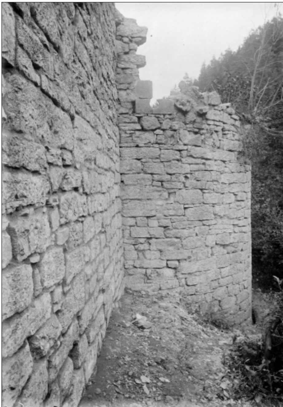
Fig. 15. Tour des fausses-braies avec meurtrière de la fin du XV e siècle (SPMS, MH n° 446, 1912).
