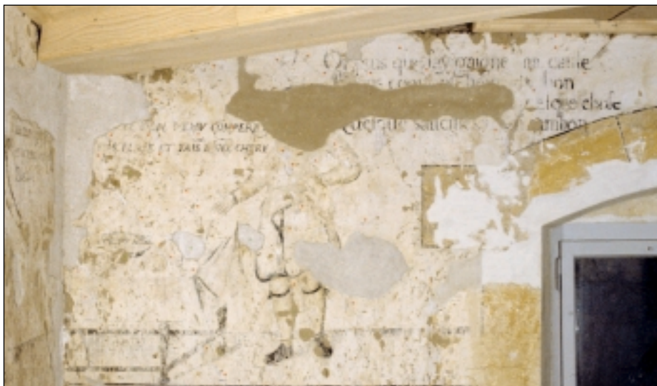
Fig. 10. Pièce 1.9, salle d'avis , paroi sud-est, octobre 1999, complément aux fig. 6 et 8 et 9. État du décor peint figuratif, des inscriptions et de l'encadrement de la fenêtre après la suppression des badigeons. Traitements en cours: colmatage des manques et des lacunes.
