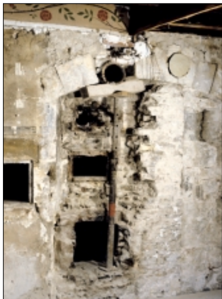
Fig. 12. Salle de justice , paroi nord, mai 1999. Détail du centre de la paroi, état des enduits après la suppression des panneaux du XX e siècle. Plusieurs installations de poêles et de canaux de cheminée témoignent des modifications et des interventions qui se sont succédé.
