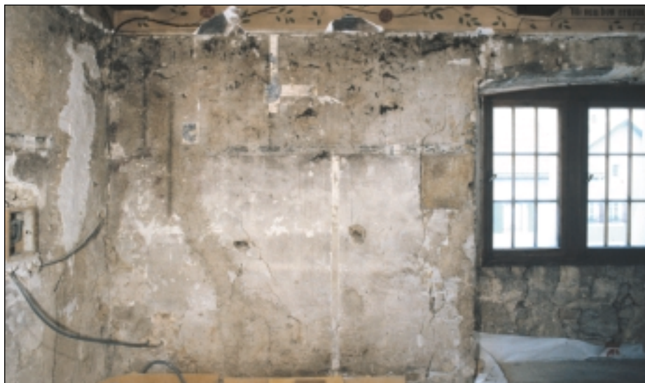
Fig. 17. Salle de justice , paroi ouest, côté sud, mai 1999. Phase préliminaire d'interventions: campagne de sondages consécutive à la suite de la suppression des panneaux installés au XX e siècle. Découverte de motifs armoriés polychromes, d'encadrements ocre jaune imitation d'un appareil et complété d'une bande inférieure ocre jaune délimitant un espace réservé aux décors peints.
