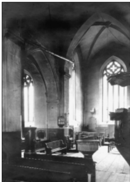
Fig. 1. Le chœur et le départ du transept. Etat de l'aménagement intérieur peu avant la restauration de 1908-1909 (archives SPMS).
