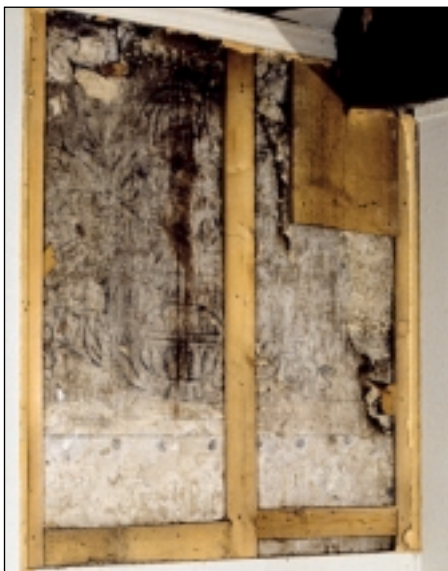
Fig. 2. Salle des gouverneurs , angle nord-ouest, juin 1992. Mise au jour d'un décor peint: suppression d'un doublage en bois aggloméré fixé sur un lambris de bois vraisemblablement posé en 1931, en même temps que le plâtre qui couvre les pierres de taille de la baie ouest.
