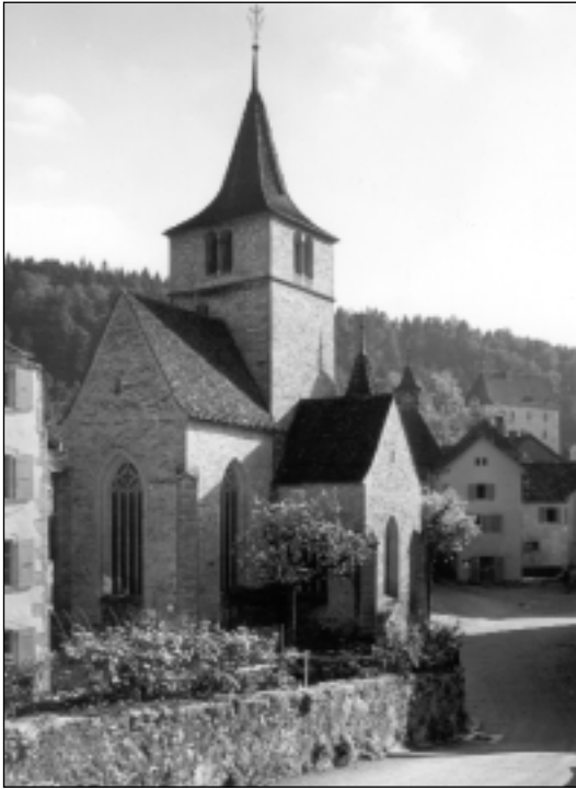
Fig. 2. Chœur et transept de la collégiale (SPMS 1957).
