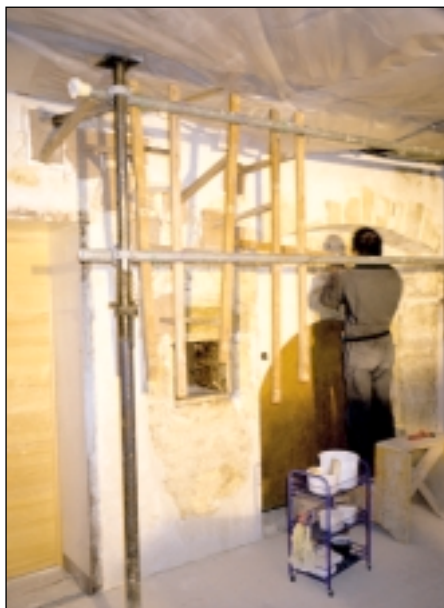
Fig. 13. Salle de justice , décembre 2000, complément à la fig. 12. Travaux en cours: consolidation et maintien sous presse des enduits anciens sans cohésion, mise au jour des décors peints et des inscriptions.
