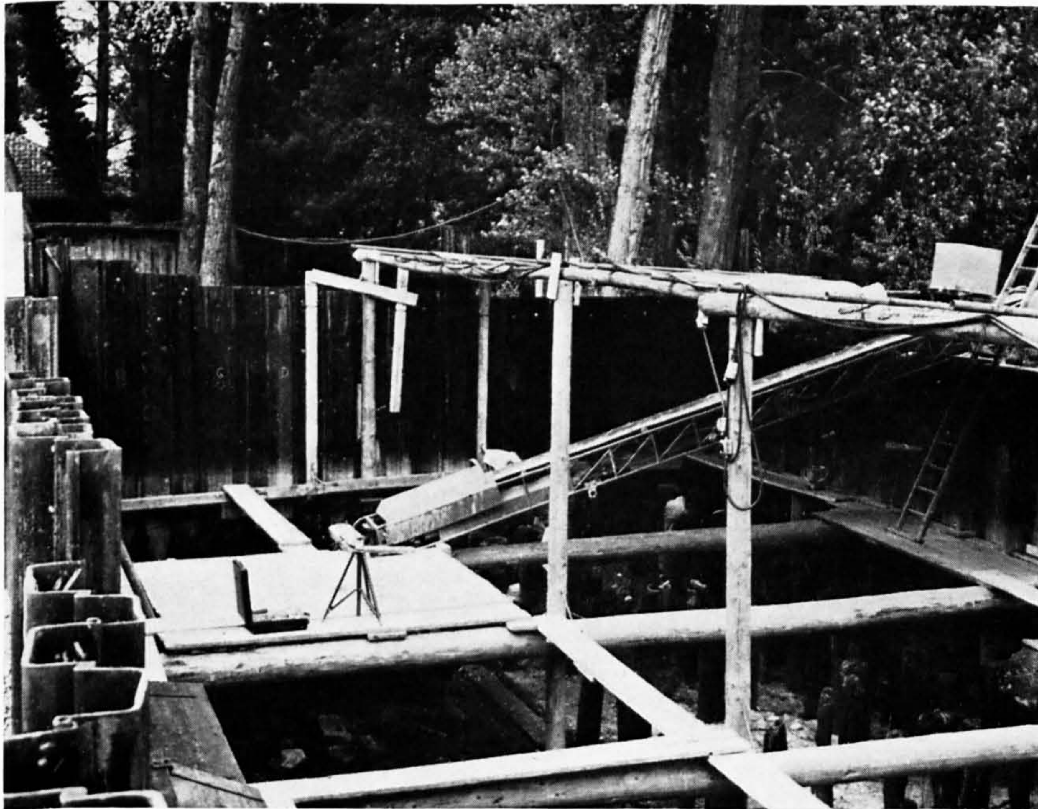
Vue du caisson, prise du sud-est. Au premier plan à droite, pilotis après enlèvement de la couche archéologique, à l'extrême droite, fossé d'écoulement.
