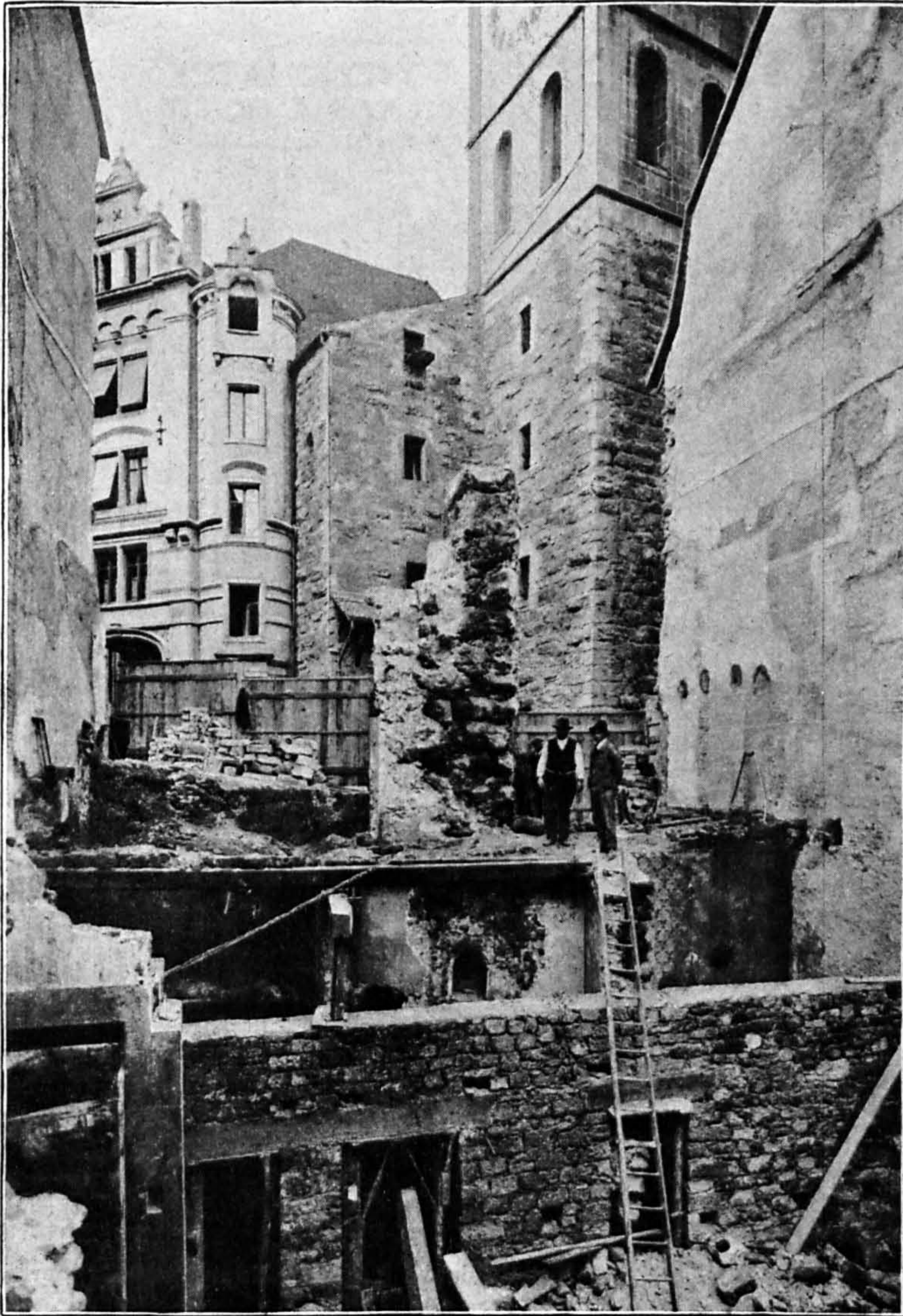
N° 3. Angle sud-est du rempart de la première enceinte de Neuchâtel. Vue prise au sud.
