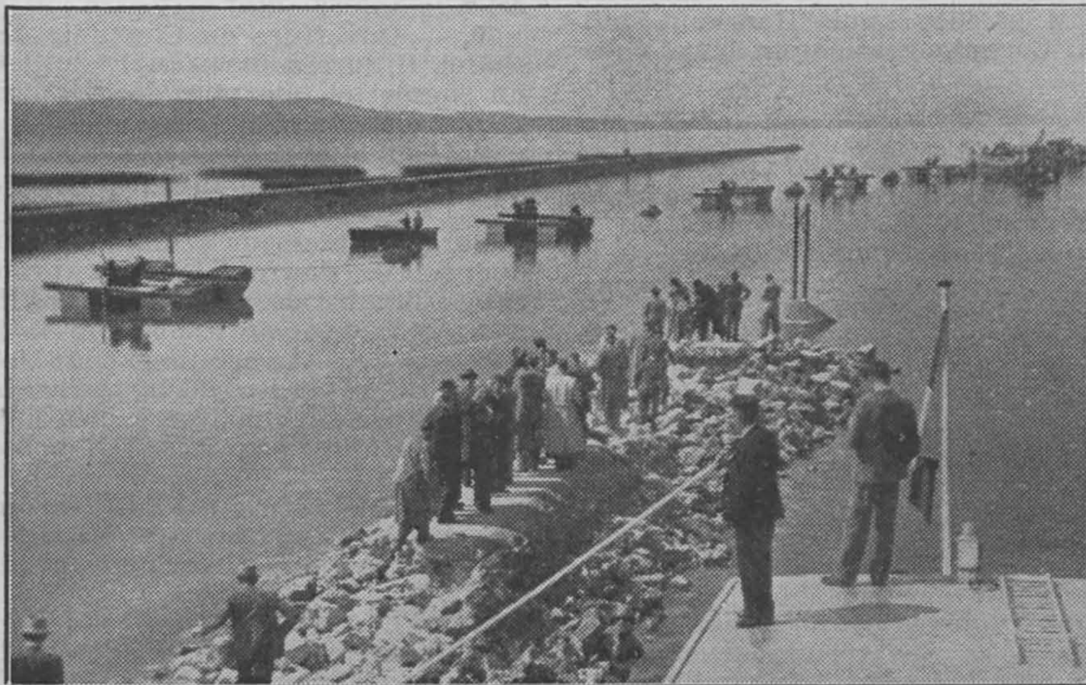
Transport de la conduite destinée à pomper l'eau du lac pour alimenter en eau potable une partie de la ville de Neuchâtel.
