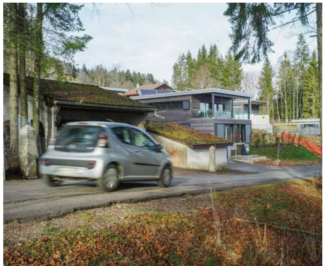
Depuis le lotissement les Endroits-Verts (ici à gauche de la route) jusqu'au carrefour Chemin Perdu, la route sera élargie et la vitesse limitée à 30 km/h. Sur le haut, ce ne sera pas le cas. CHRISTIAN GALLEY
