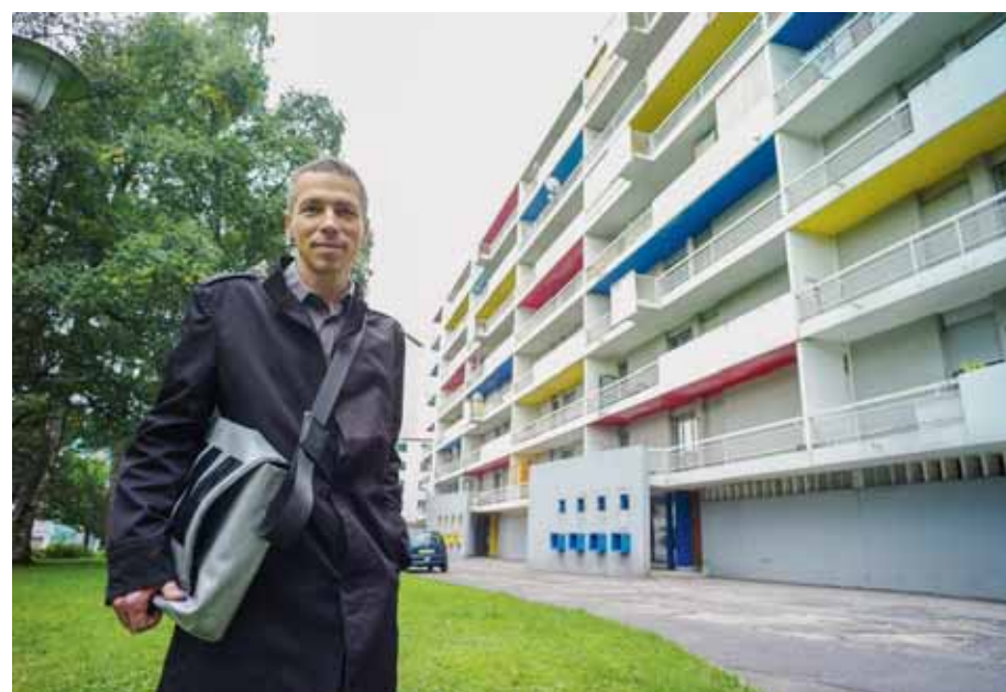
Boris Evard devant les immeubles Numaga à la rue Numa-Droz (bâti en 1954-1955) d'André Gaillard, qui vient de disparaître. «Ceux-ci représentent un manifeste de l'influence de Le Corbusier à La Chaux-de-Fonds», dit l'architecte. CHRISTIAN GALLEY
